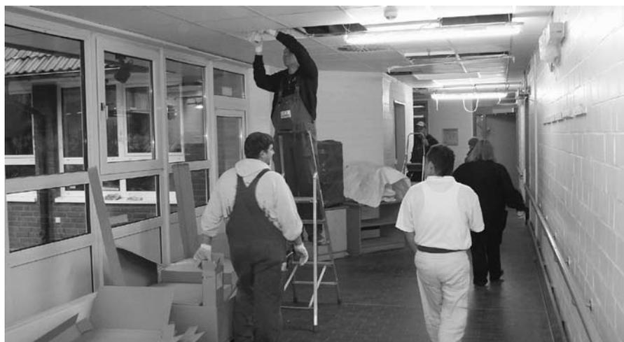
Die Flure bekamen neue, schallisolierende Decken
