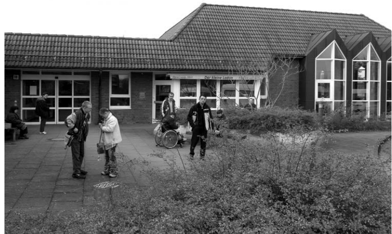
Der Eingangsbereich des Betriebes Elbe 6 in Bergedorf
