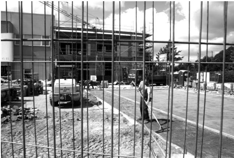
Fotos: Eindrücke während der Bauphase
